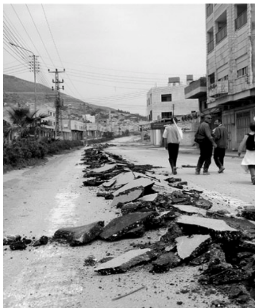
Naplouse, 15 avril 2002 Destruction de la route reliant le camp de Balata à Naplouse.
