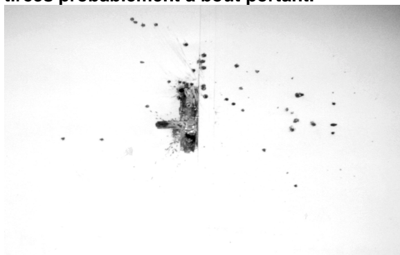
Jénine, Hopital de l'UNRWA, 19 avril 2002 Porte au 1 er étage donnant accès aux salles de soin et aux bureaux.
