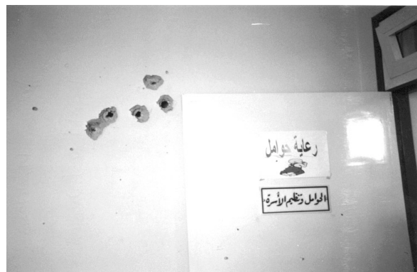
Jénine, Hopital de l'UNRWA, 19 avril 2002 Bureau mitraillé, 1 er étage
